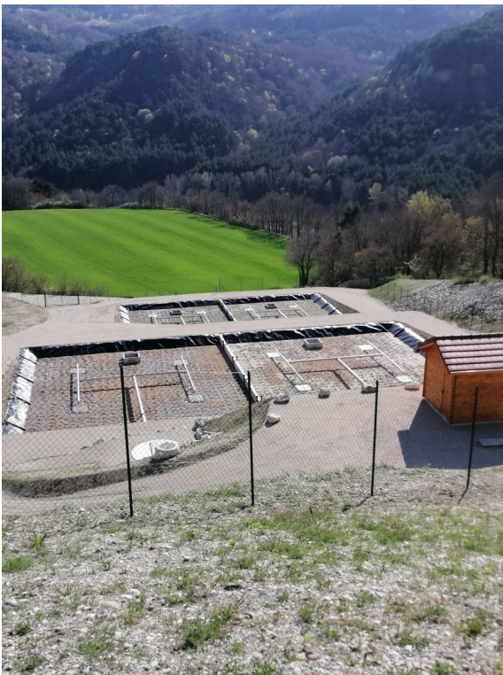
Photo ci-dessus : fin du chantier
